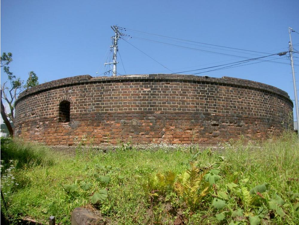
大正3年に市内間下南側の塚間川の西方一帯の製糸工場への給水のために建設されました。天竜川にポンプを設置し、導管によりタンクまで水を揚げました。現在は、丘の上に外形12m、7.3m、3.1mの三重円筒型(壁の厚さ約61cm)の巨大なレンガ積が残されています。
