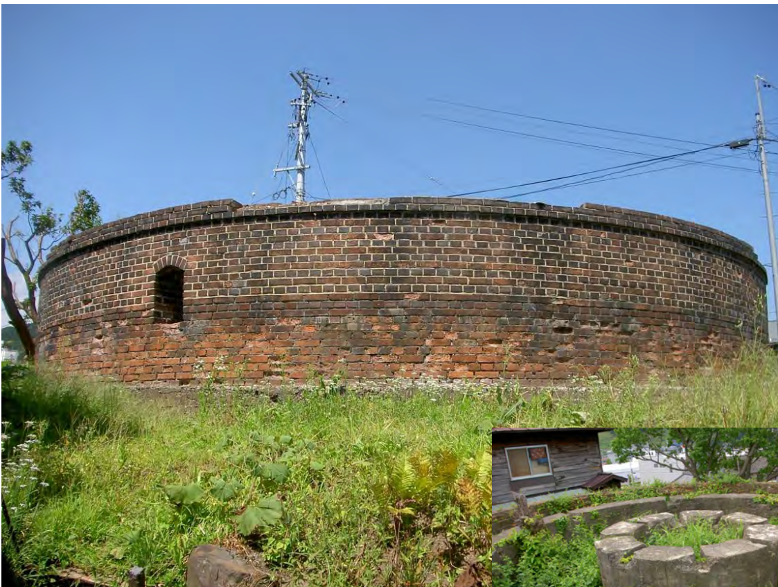
金属製タンクを乗せたレンガ積の台座が残る。
