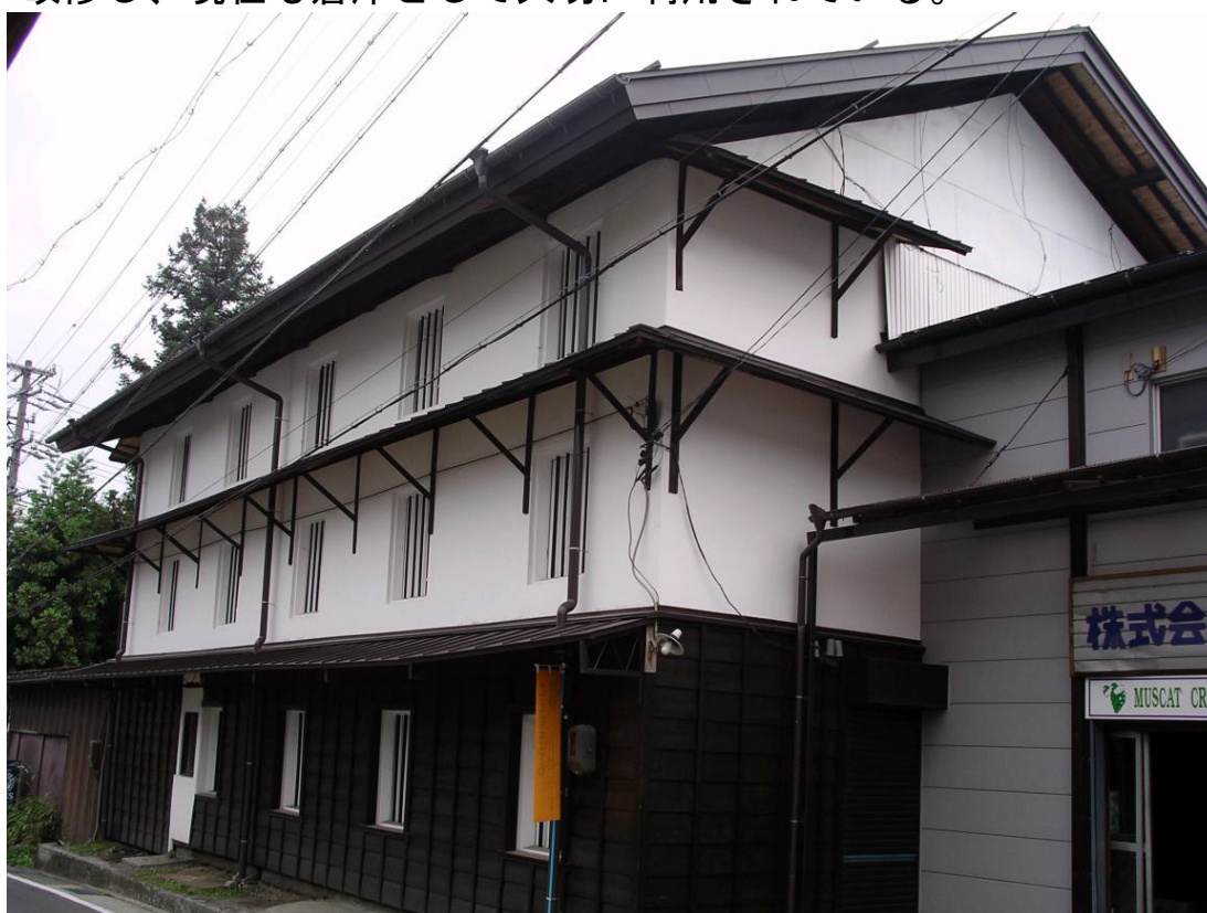
現在も使用されている株式会社金上繭倉庫。
