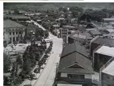
写真左側が旧庁舎 右下側が諏訪倉庫
